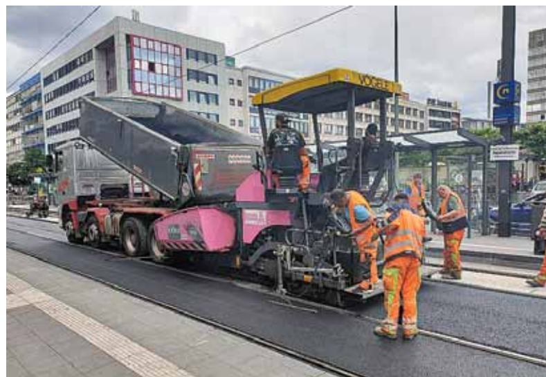
BusPhalt ist am Nahverkehrsknotenpunkt „Konstablerwache“ eingesetzt worden. Foto: A+L
